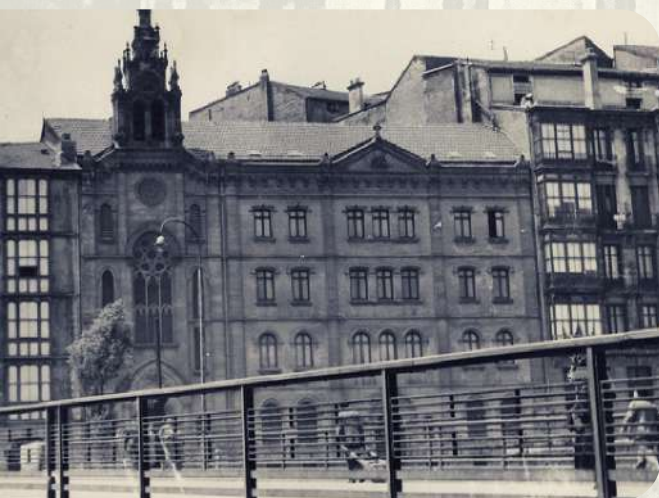
Casa Madre antigua, Bilbao.
